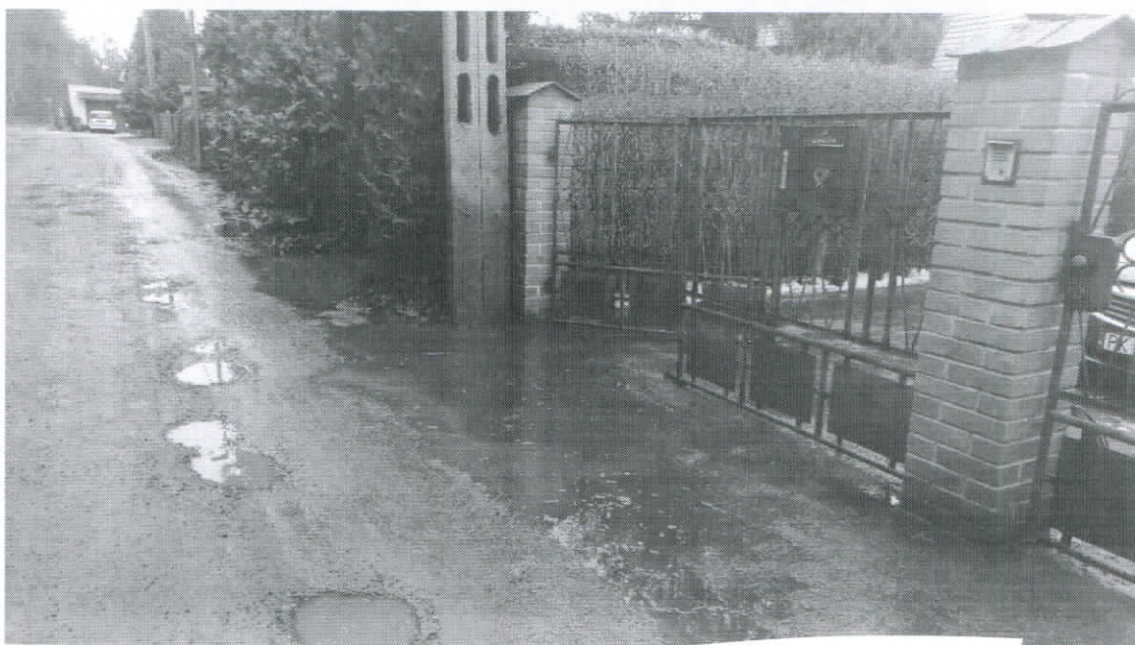
Fot. 4. Zalegająca woda na podjeździe do posesji
