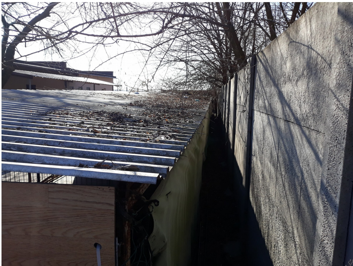
Boksy do rozbiórki tylna ściana
