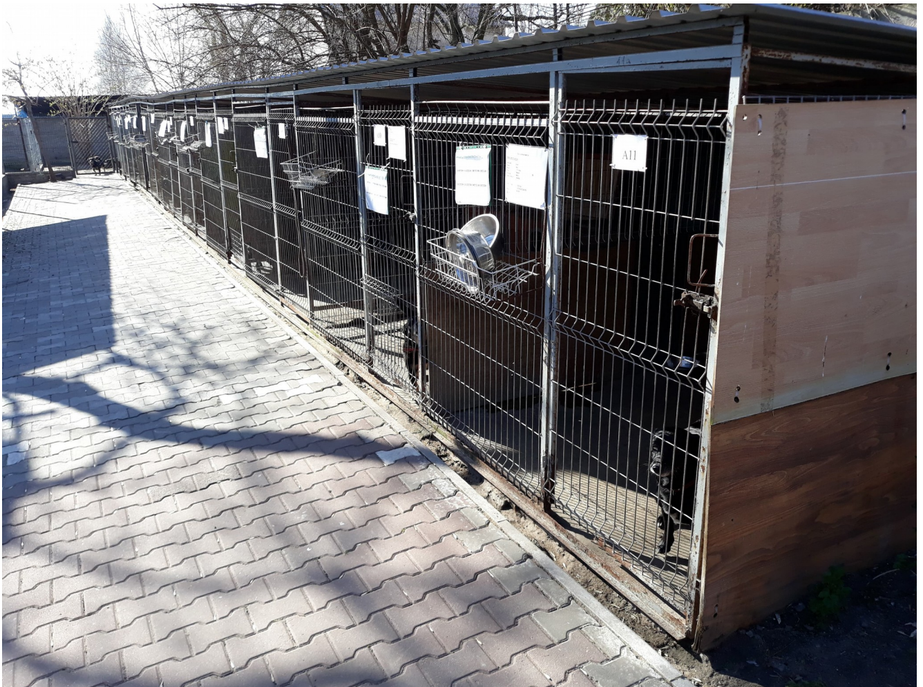
Boksy do rozbiórki przednia ściana
