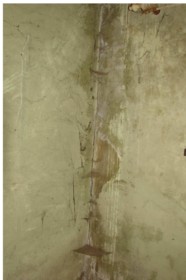
Nr 8. Spękania pionowe na łączeniu ścian nośnych i odpadający płatami tynk wewnętrzny.
