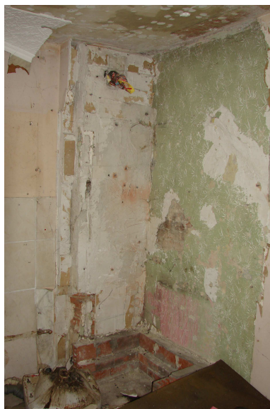
Nr 8. Spękania pionowe na łączeniu ścian nośnych i odpadający płatami tynk wewnętrzny.
