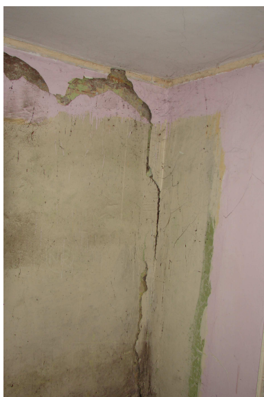
Nr 9. Spękana ściana szczytowa południowa na całej grubości i wysokości oraz wychodząca z pionu.
