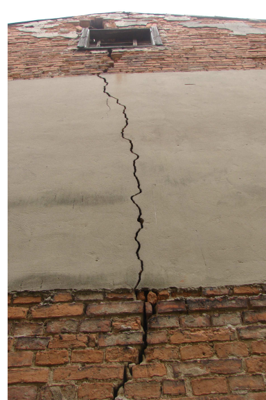
Nr 7, Spękana od wewnątrz i zewnątrz szczytowa ściana południowa.
