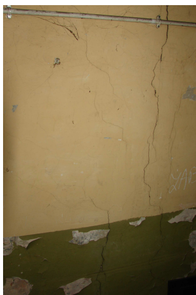
Nr 7, Spękana od wewnątrz i zewnątrz szczytowa ściana południowa.
