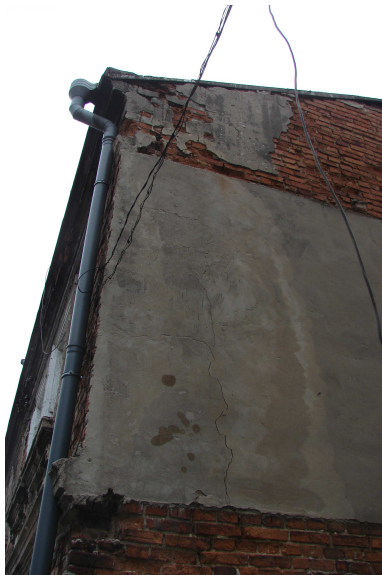
Nr 3. Zbliżenia na pokazanie spękań ściany szczytowej oraz gzymsu.
