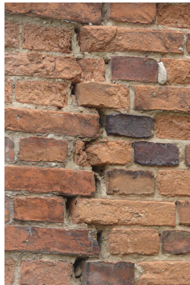
Nr 3. Zbliżenia na pokazanie spękań ściany szczytowej oraz gzymsu.
