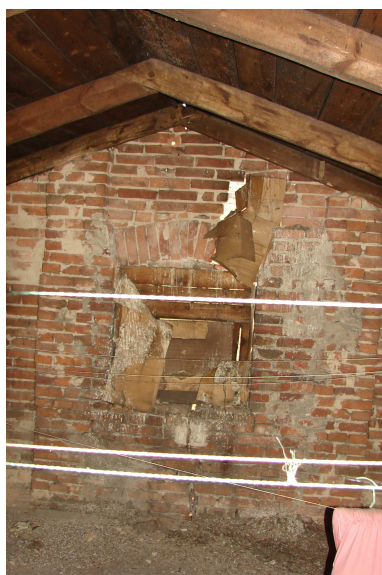
Nr 9. Spękana ściana szczytowa południowa na całej grubości i wysokości oraz wychodząca z pionu.
