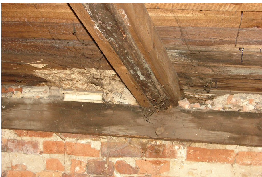
Nr. 27. Wzmocnienie porażonej krokwi grzybami i owadami poprzez dobicie z boku bali, ale korozja biologiczna trwa dalej i obejmuje nowo dobite bale drewniane.
