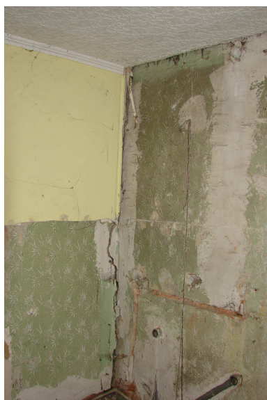
Nr 9. Spękana ściana szczytowa południowa na całej grubości i wysokości oraz wychodząca z pionu.
