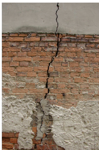
Nr 7, Spękana od wewnątrz i zewnątrz szczytowa ściana południowa.
