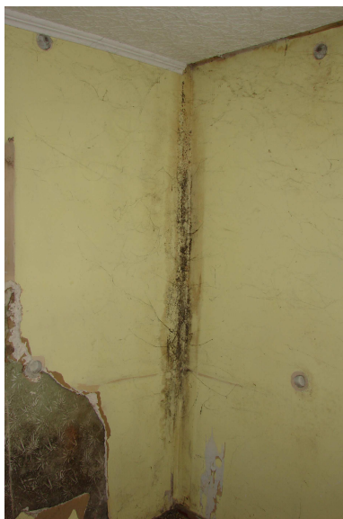
Nr 8. Spękania pionowe na łączeniu ścian nośnych i odpadający płatami tynk wewnętrzny.
