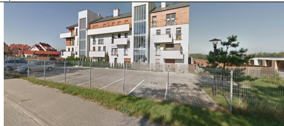
Fot. 3 Widok na budynek wielorodzinny znajdujący się po przeciwległej stronie ulicy Poligonowej
