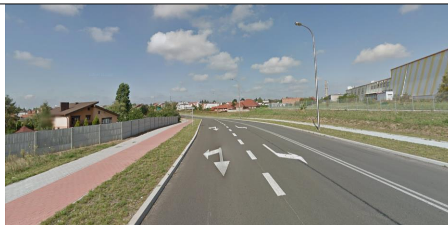
Fot. 6 Widok na ulicę Włókniarzy
