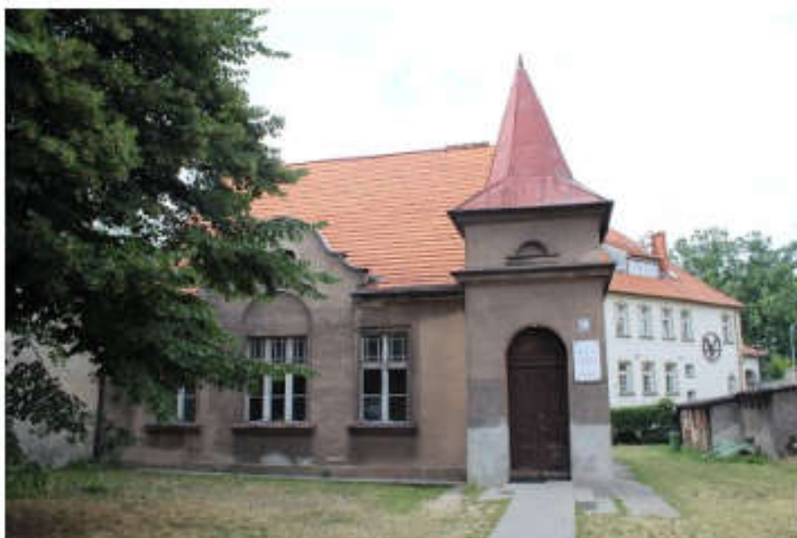
Zdjęcie 5 Kościół Zboru Baptystów w Kaliszu - elewacja frontowa budynku – adres: Podgórze 1, działka nr ewid. 102, obręb 036 Śródmieście II, czas powstania: lata 1925-1927 (źródło: Ocena (opis) stanu istniejącego wraz z analizą fotograficzną na potrzeby miejscowego planu rewitalizacji „Jabłkowskiego-Podgórze” w Kaliszu – Miasta Kalisza, 2020 rok)
