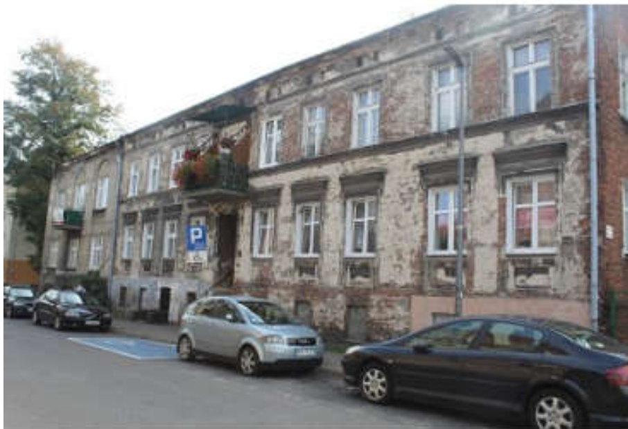
Zdjęcie 3 Budynek mieszkalny z pawilonem handlowym na posesji - adres - Podgórze 8 – 10, działka nr ewid. 118, czas powstania: ok. 1901, przebudowany w 1908 roku (źródło: Ocena (opis) stanu istniejącego wraz z analizą fotograficzną na potrzeby miejscowego planu rewitalizacji „Jabłkowskiego-Podgórze” w Kaliszu – Miasta Kalisza, 2020 rok)
