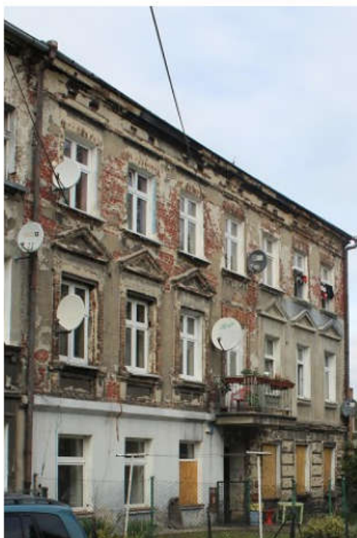
Zdjęcie 6 Budynek mieszkalny - adres: Gołębia 1, działka nr ewid. 115, obręb 036 Śródmieście II - czas powstania: ok. 1910 rok (źródło: Ocena (opis) stanu istniejącego wraz z analizą fotograficzną na potrzeby miejscowego planu rewitalizacji „Jabłkowskiego-Podgórze” w Kaliszu – Miasta Kalisza, 2020 rok)
