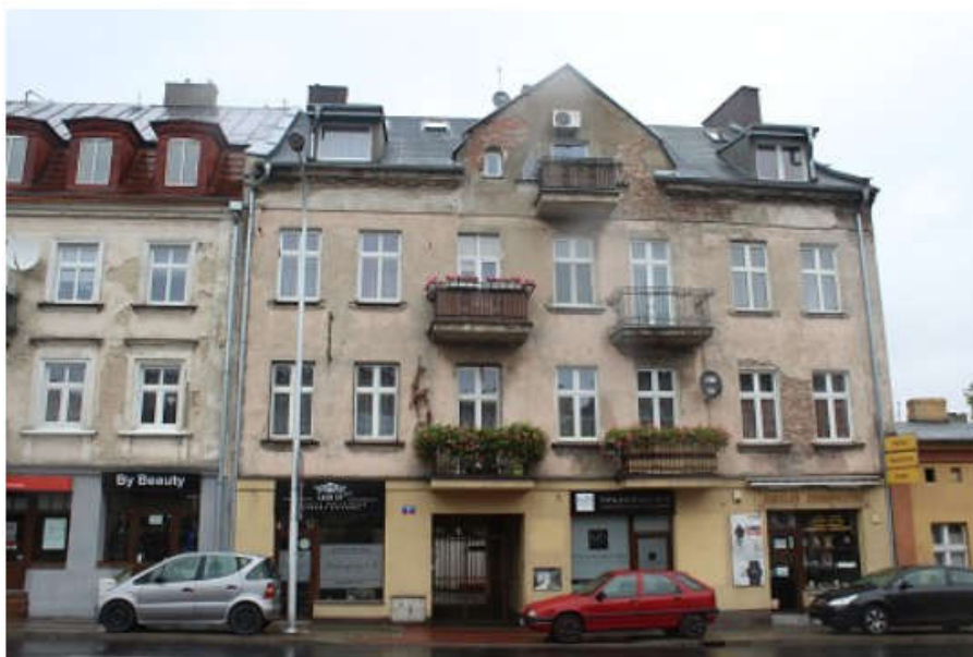
Zdjęcie 2 Budynek mieszkalny z lokalami użytkowymi w parterze – adres: Harcerska 7, działka nr ewid. 126 obręb 043 Rogatka, czas powstania: ok. 1910 rok (źródło: Ocena (opis) stanu istniejącego wraz z analizą fotograficzną na potrzeby miejscowego planu rewitalizacji „Jabłkowskiego-Podgórze” w Kaliszu – Miasta Kalisza, 2020 rok)
