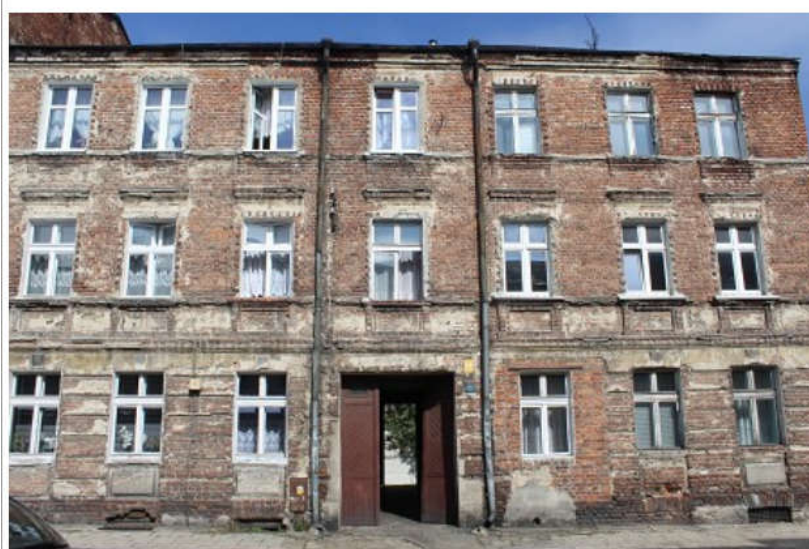
Zdjęcie 7 Elewacja frontowa i wejście główne do budynku - adres: Podgórze 11, działka nr ewid. 112, obręb 036 Śródmieście II, czas powstania: ok. 1900 rok (źródło: Ocena (opis) stanu istniejącego wraz z analizą fotograficzną na potrzeby miejscowego planu rewitalizacji „Jabłkowskiego-Podgórze” w Kaliszu – Miasta Kalisza, 2020 rok)
