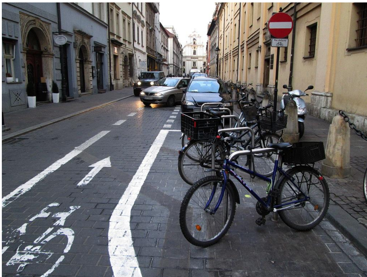
Fot. 14. Stojaki rowerowe zlokalizowane w jezdni w obrębie skrzyżowania. Poprawia to widoczność wzajemną i eliminuje ryzyko nieprawidłowego parkowania. Ul. św. Jana, Kraków.
