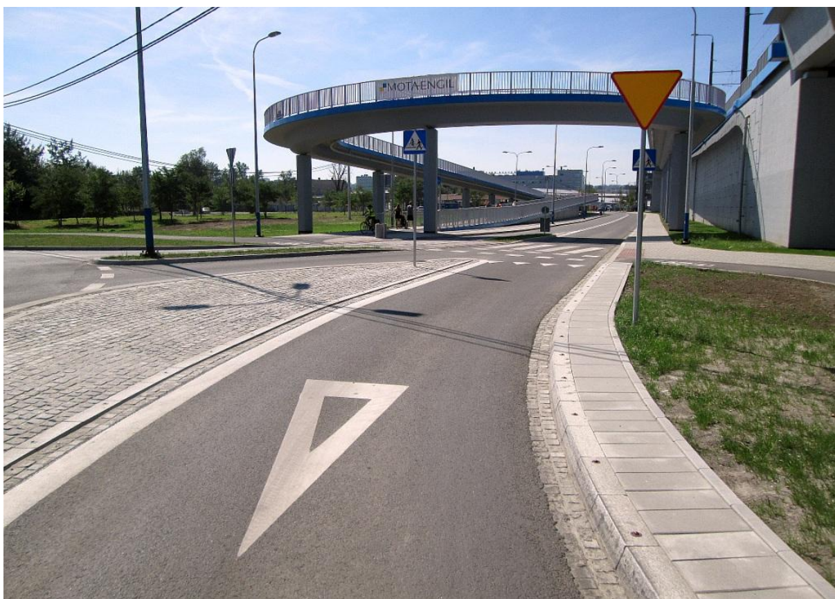
Fot. 12. Poprawne oznakowanie przejazdu dla rowerzystów przecinającego łącznicę („bypass”). Za znakiem poziomym P-15 i pionowym A-7 widać znak D-6b który nie ustala pierwszeństwa i jest jedynie znakiem informacyjnym. Przed przejazdem dla rowerzystów wyznaczono linię zatrzymań złożoną z trójkątów (P-13). Kraków, ul. Saska.
