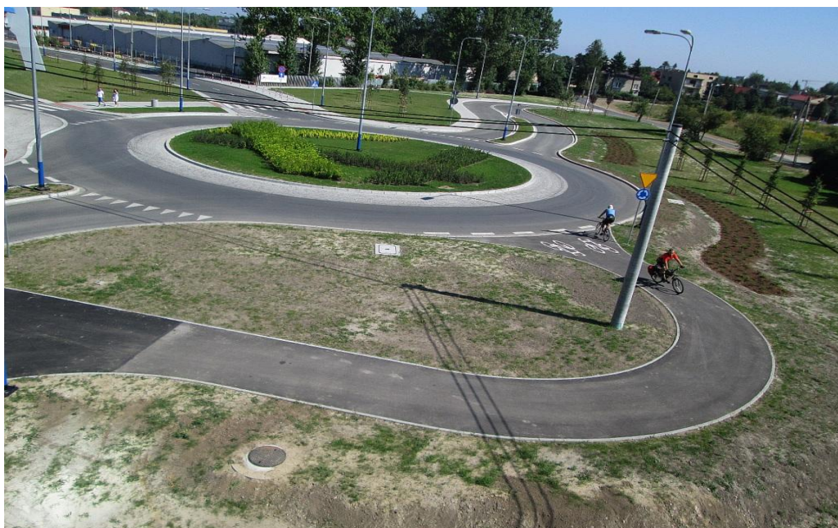
Rys. 23A. Dwukierunkowa droga dla rowerów jako samodzielny wlot małego ronda.
