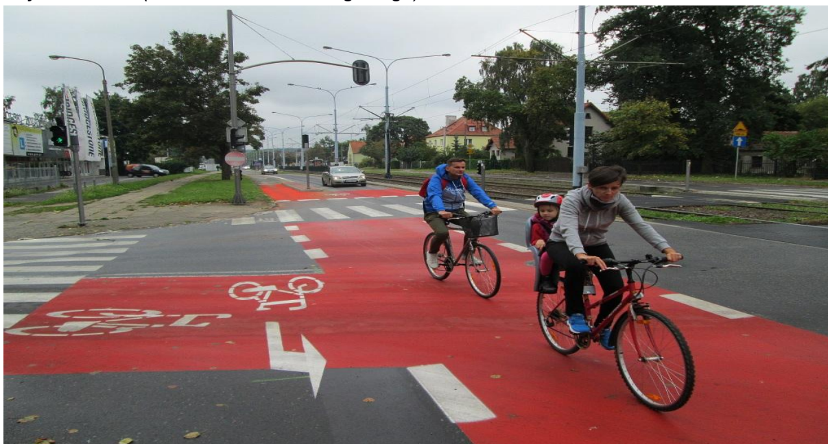
Fot. 9. Śluza typu 2, Gdańsk, ul. Wojska Polskiego. W głębi widoczna na wlocie śluza klasyczna, typu 1. Uwaga: zdjęcie przedstawia rozwiązanie eksperymentalne (rok 2013). W niniejszych standardach proponuje się nieco inne oznakowanie poziome śluzy typu 2, zgodnie z przepisami po nowelizacji z 2015 roku (Dz. U. z 2015 r. poz. 1314).
