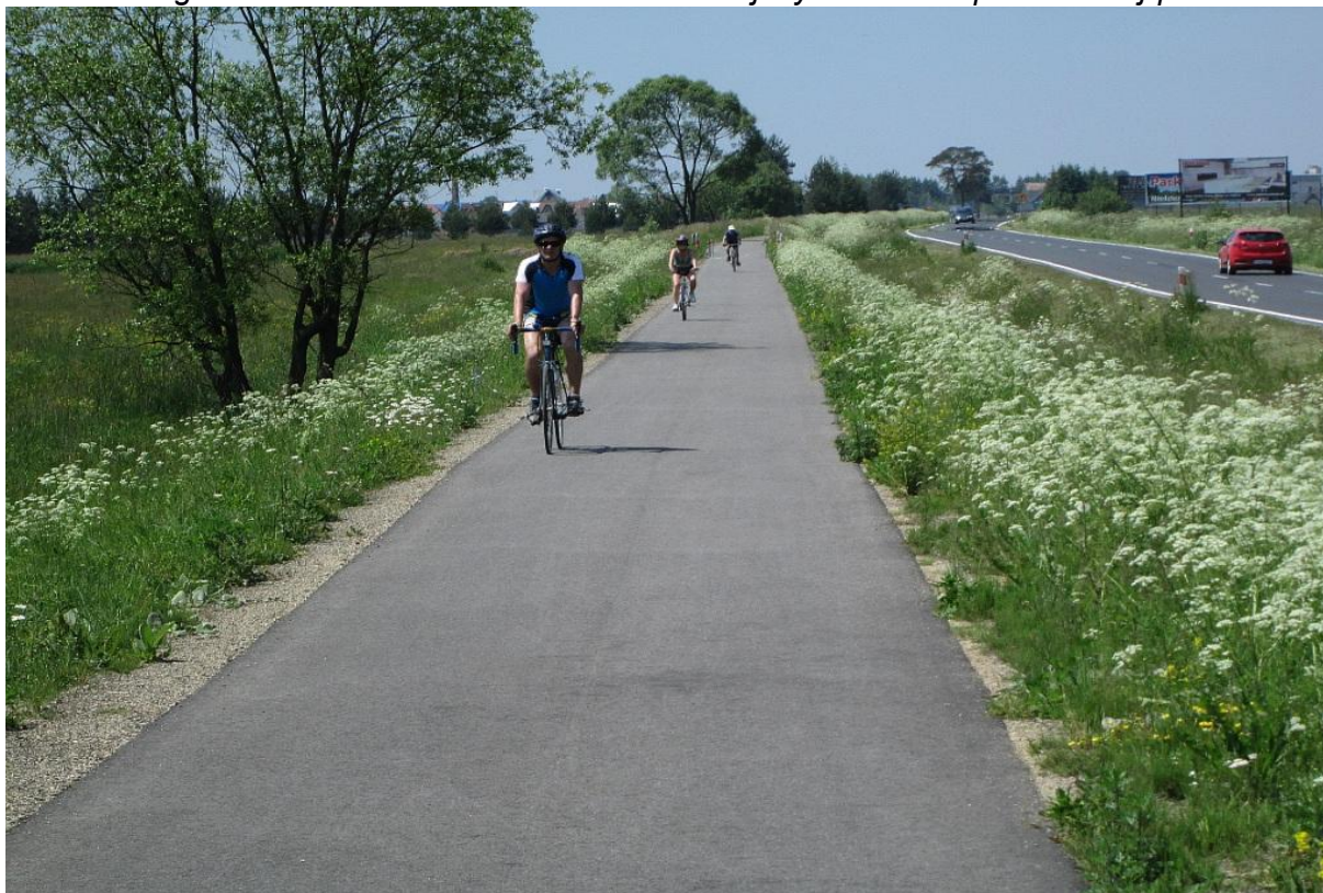
bez zbędnych i podnoszących koszty obrzeży lub krawężników. Droga wojewódzka nr 957, fragment trasy rowerowej euroregionu Tatry Nowy Targ – Sucha Hora/Trstena (Słowacja).
